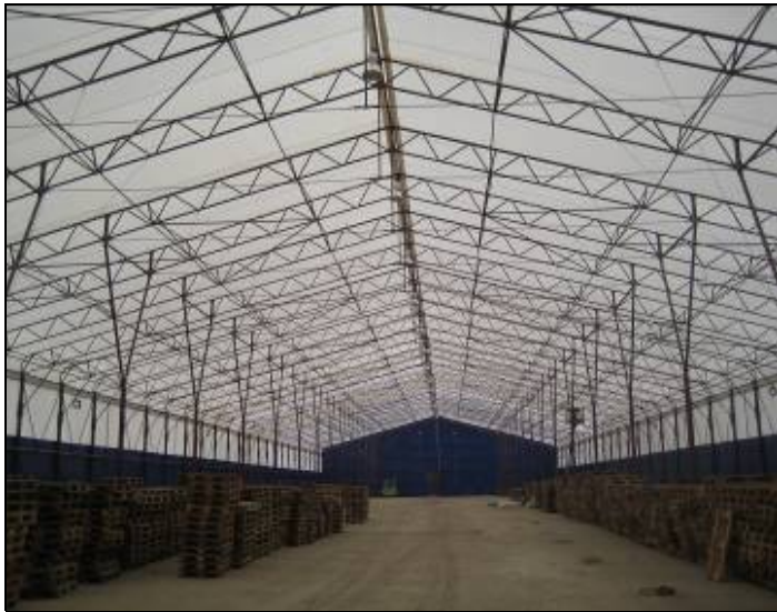
Комбинированный склад из профлиста и тента размерами 26,7x92x6,5 в Воронежской области.
